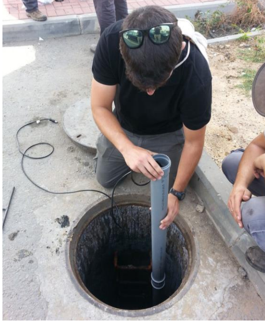
התקנת מערכת חיישנים לניטור שפכי תעשייה , קריית עקרון
