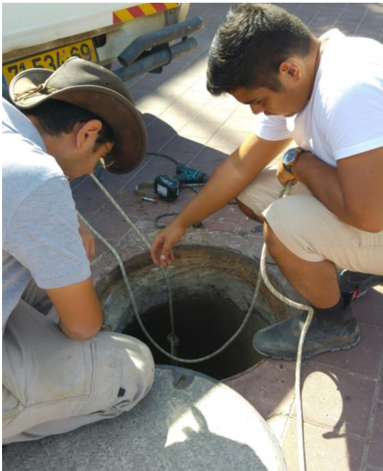
התקנת מערכת חיישנים, ניטור שפכי תעשייה
