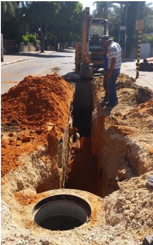
החלפת קווי ביוב רחוב משה שרת, קריית עקרון החלפת קווי מים רחוב נתיב השיירות, מזכרת בתיה.
