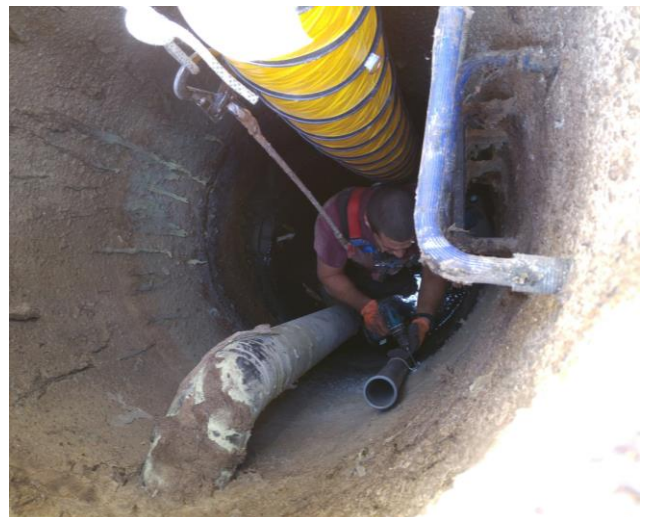
התקנת מערכת חיישנים, ניטור שפכי תעשייה
