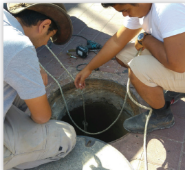
התקנת מערכת חיישנים, ניטור שפכי תעשייה
