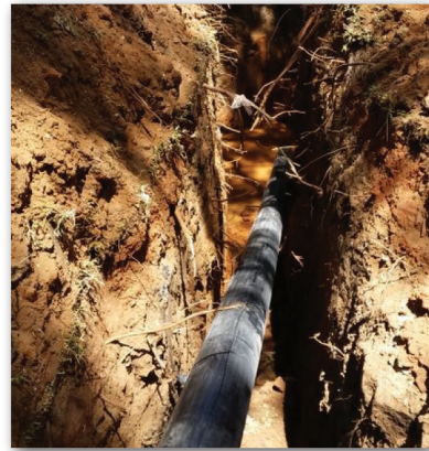
עבודות תיקון פיצוץ בקווי מים, מזכרת בתיה
